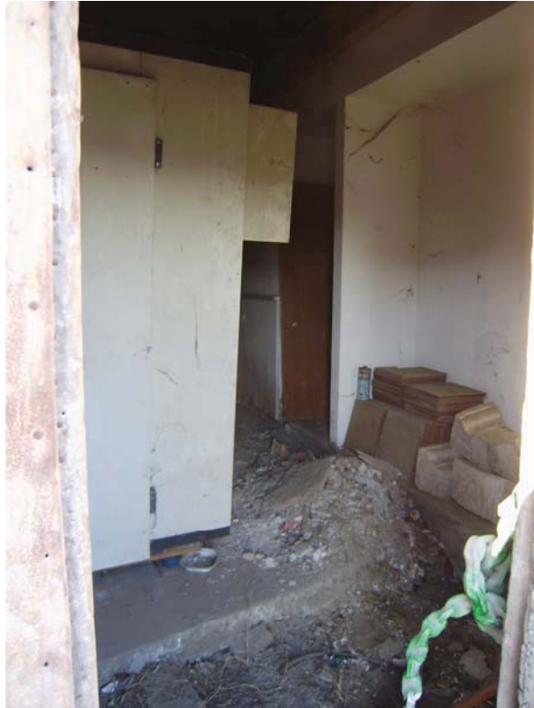
FOTO N° 7 – Ingresso (a sinistra una vecchia cella frigorifera).
