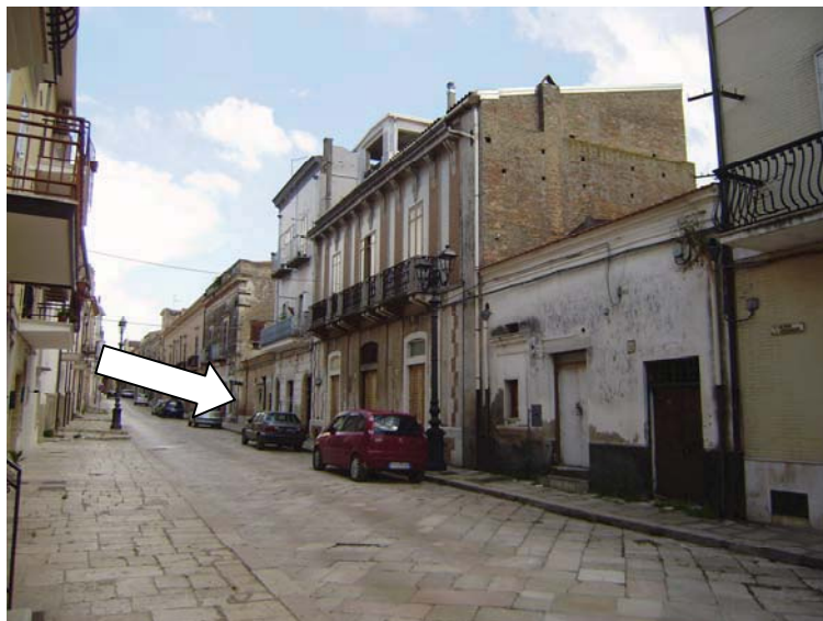
FOTO N° 6 – Vista dell'isolato da via Fiani ad angolo con via Iachino.
